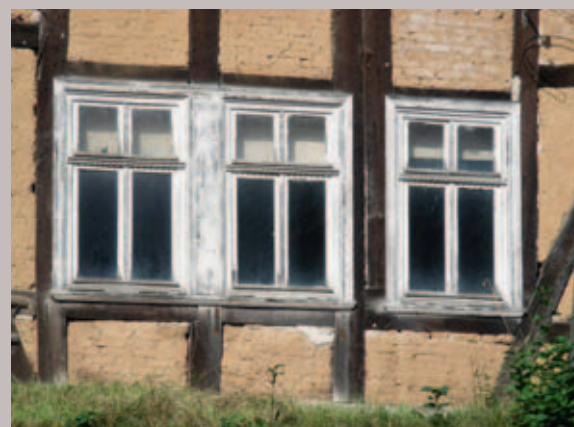
Fensterdrilling an einem barocken Fachwerkhaus
