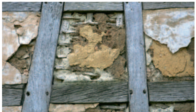
Altes Fachwerk mit Lehmfüllung
