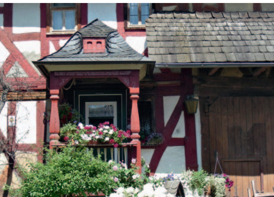
Ein später angesetzter Vorbau aus dem Historismus
