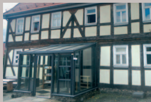
Schlichter Windfang an einem Kulturdenkmal in Hopfmannsfeld
