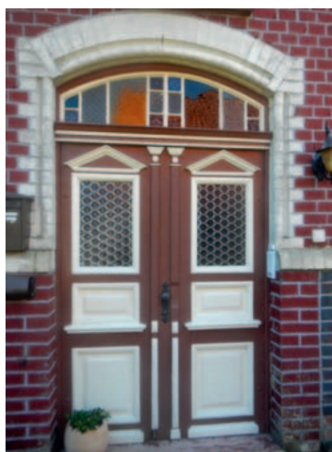
Wärmetechnisch verbesserte Tür aus dem Historismus
