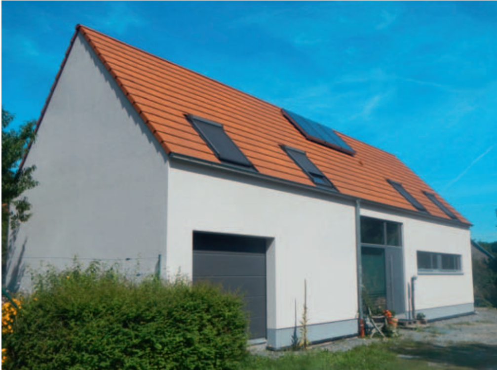
Ersatzbau für eine Stallscheune im vorderen Odenwald
