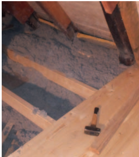
Aufdeckendämmung mit Nut und Federabdeckung.
