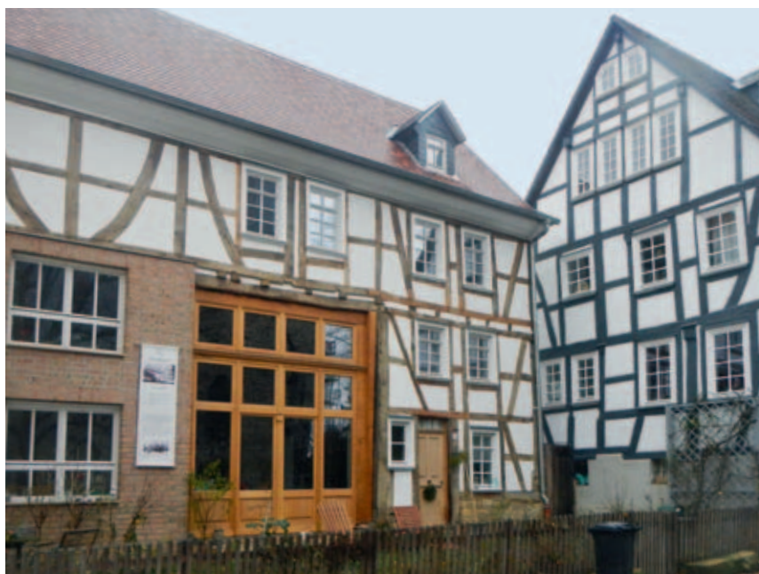
Umgebaute Scheune in der Wetterau
